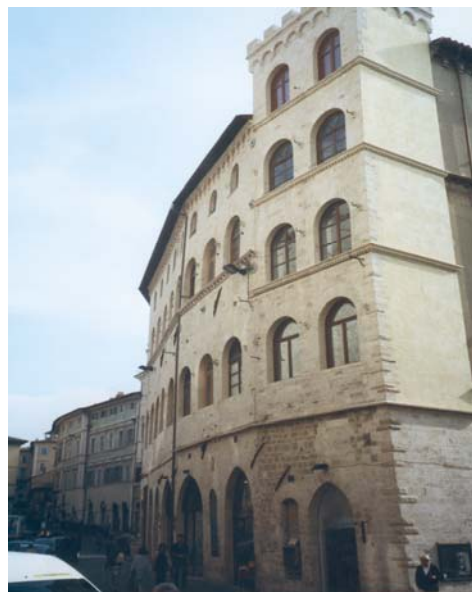
Edificio Vannucci Restaurado
